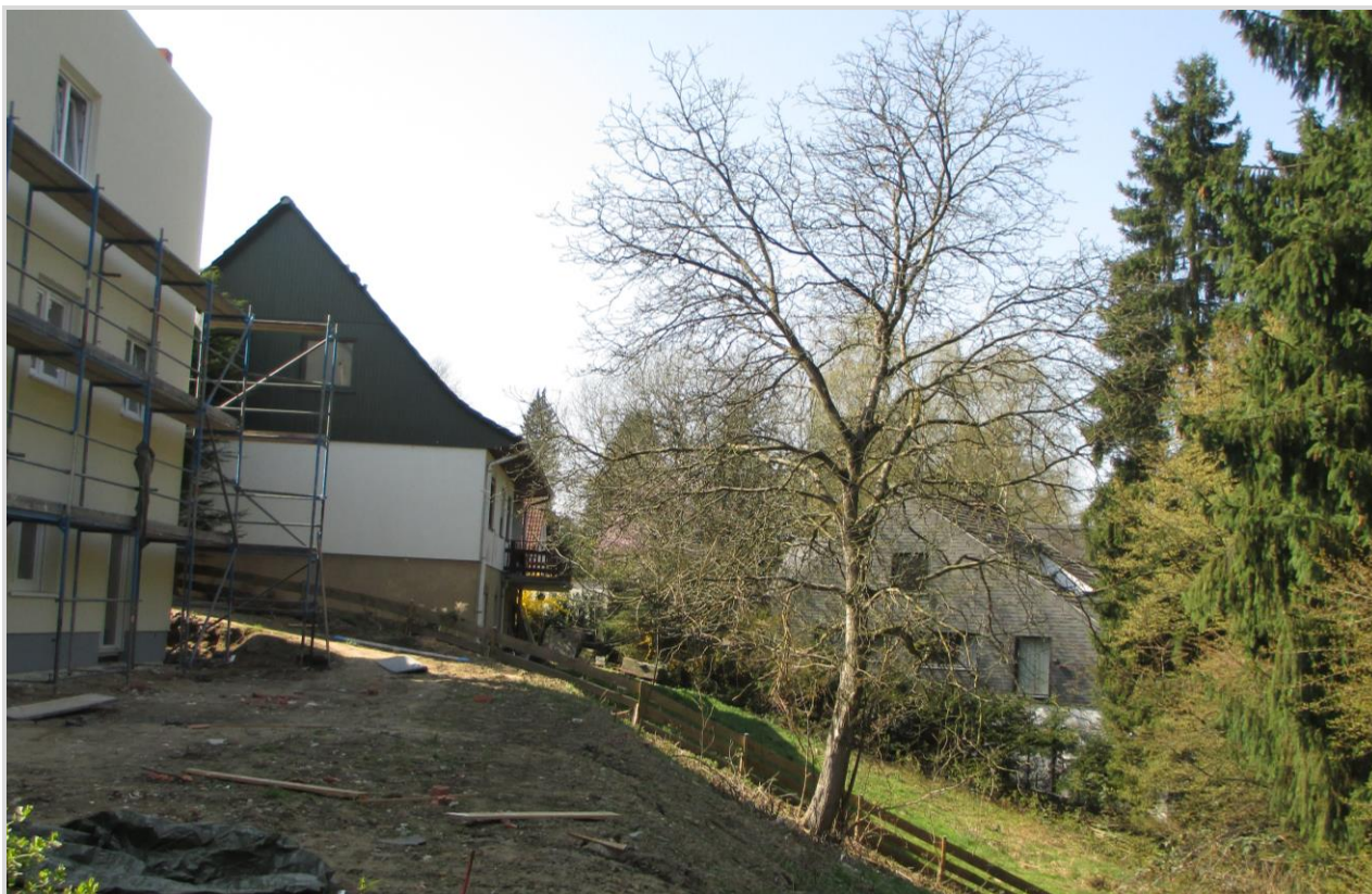
Abb. 3: Ausschnitt der Flurstücke 2931 (Jägerstraße 2 a, im Hintergrund) und 2932 (Jägerstraße 2, Baustelle im Vordergrund) aus Richtung Norden (Foto: Büro Rietmann 2013)
