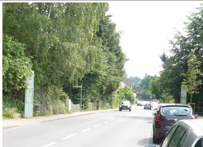
Foto 5: Blick von Norden auf die Haltestelle
